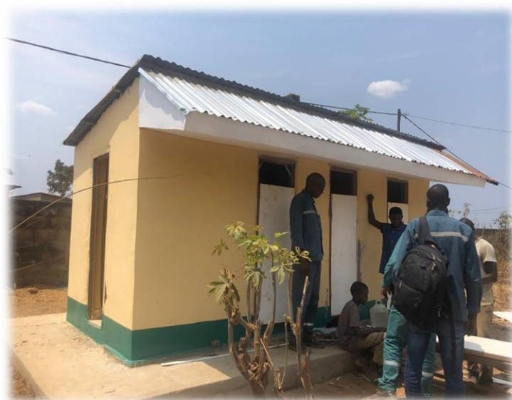
Figure 22 : Réhabilitation des latrines
