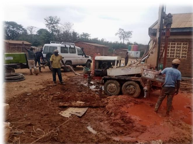
Figure 31 : Les premiers travaux
