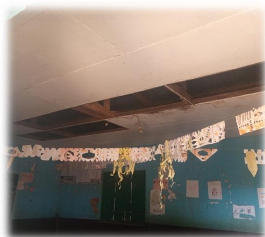
Figure 21 : Etat des salles de classes avant la réhabilitation
